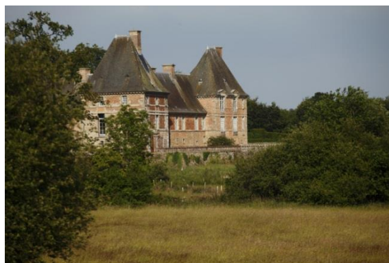
Château de Carrouges depuis les étangs asséchés © David Bordes - Centre des monuments nationaux
